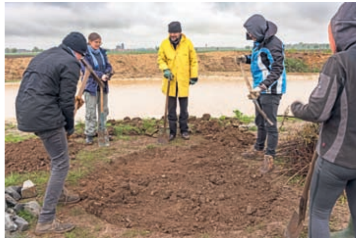
Aushub für Natursteinhaufen herstellen
